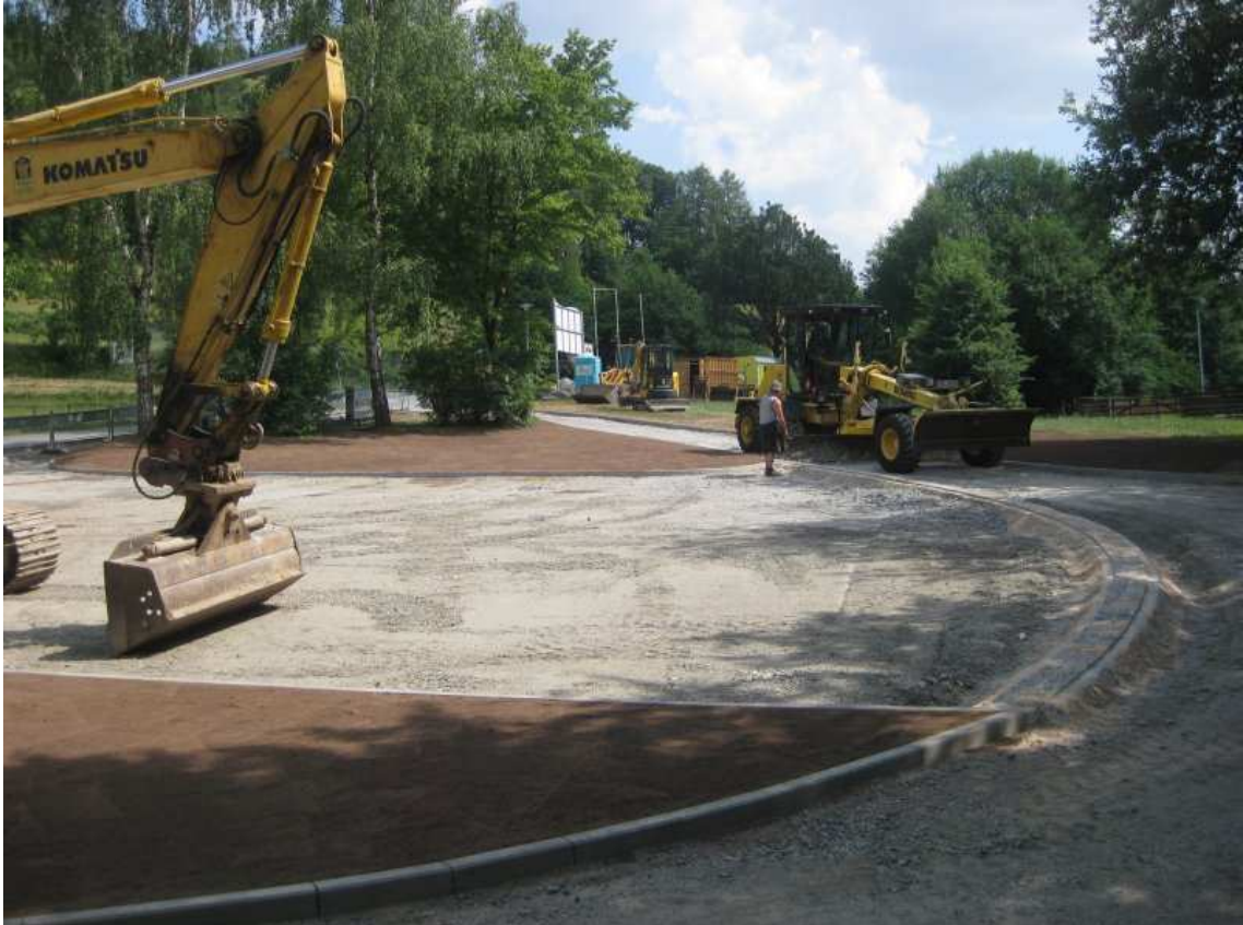
Foto: Gut voran gehen die Bauarbeiten am Felsenmeerparkplatz.
