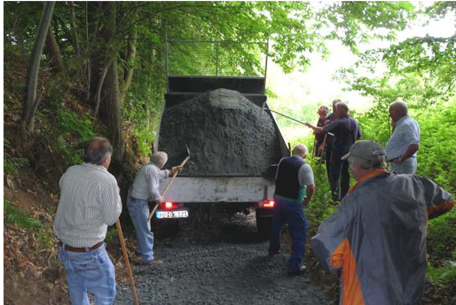
Der Gemeinde-Unimog liefert den Schotter an, der von den Helfern verteilt wird.
