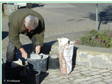
Nachdem der Sockel dieser Bank bereits Ende des letzten Jahres neu aufgebaut war, dichtete ihn Klaus Essinger mit einer dicken Dichtungsschlämme ab (Bild links), damit kein Wasser in das neue Mauerwerk eindringen und vor allem im Winter sein zerstörerisches Werk vollbringen kann. Dann musste das ganze über die Wintermonate aushärten.
