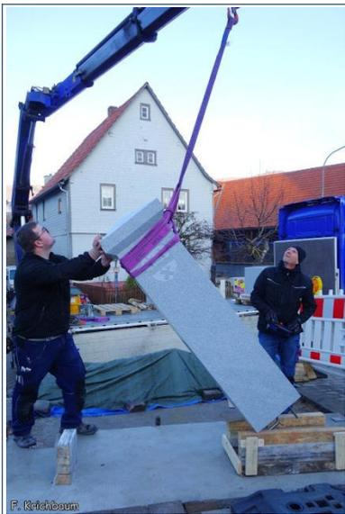
Endlich traf er ein, beladen mit den vier schwergewichtigen Grantteilen des neuen Brunnens. Damit die Brunnensäule felsenfest steht, mussten noch zwei Löcher von 20 mm Durchmesser und 25 cm Tiefe in das Betonfundament gebohrt werden, in denen die beiden Bolzen, die bereits im Fuß der Säule eingeklebt waren, mit Spezialkleber verankert werden konnten.
