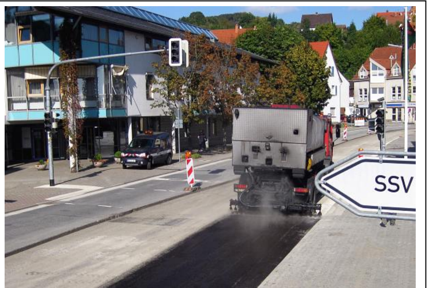
Am Donnerstag und Freitag wurde für die rechte Fahrspur der B 47 Asphalt aufgetragen.
