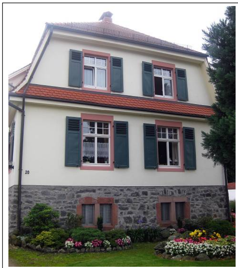
Fast fertig ist die Sanierung des denkmalgeschützten Wohnhauses Falltorweg 20
