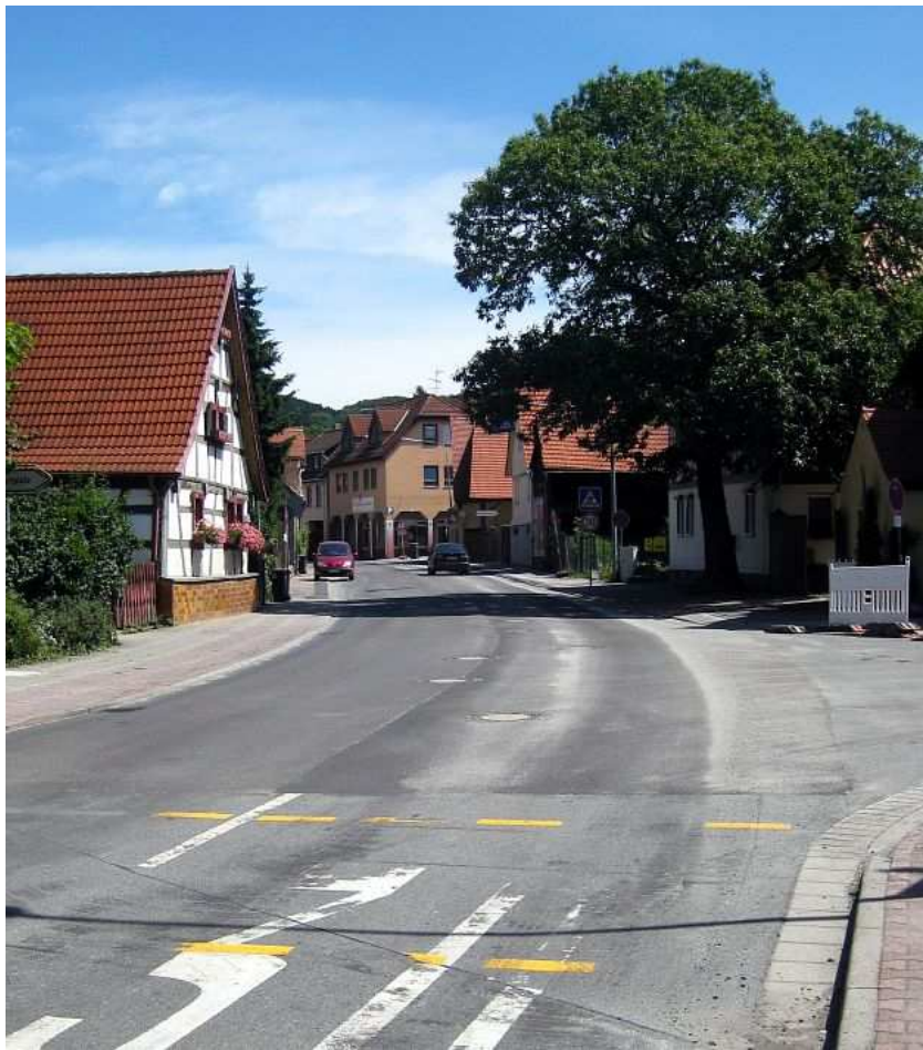
Abgeschlossen wurde jetzt die Sanierung der B 47 im Unterdorf
